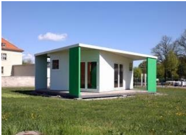
Musterhaus des Fraunhofer-Instituts in Halle (Saale), das 2016 aus NCL-Paneelen gebaut wurde und bis heute keinerlei Anzeichen von Verwitterung aufweist.
