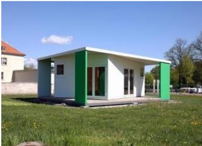
*Musterhaus des Fraunhofer-Instituts in Halle (Saale), das 2016 aus NCL-Paneelen gebaut wurde und bis heute keinerlei Anzeichen von Verwitterung aufweist.*
